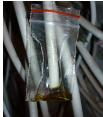
Пролив трассы (водопровод)
